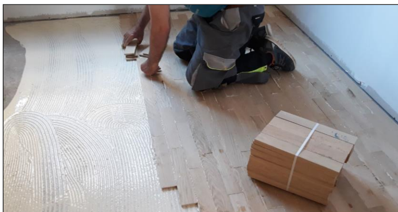
Fig. 4: Proceso de colocación de las tablillas de un parqué clásico variante lamparqué.
