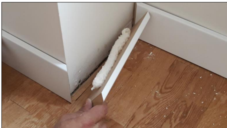
Fig. 5: Acabado del encuentro perimetral de un pavimento. Colocación de los rodapiés fijados con espuma y saetines.
