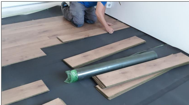
Fig. 3: Replanteo, presentación y corte de las lamas de una tarima flotante.
