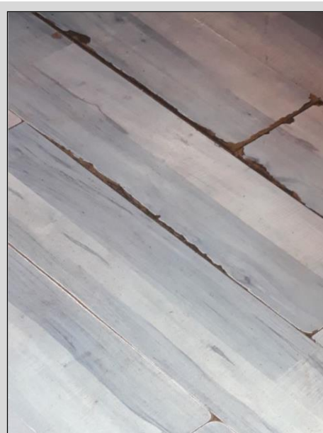
Fig. 11: Vista del interior de un edificio que tiene un pavimento de entablillado con huecos entre los cantos de las piezas.
