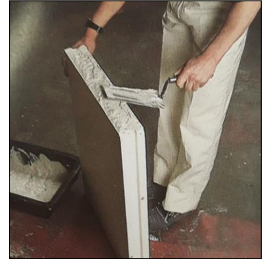
Fig. 4: Aplicación de adhesivo sobre el canto hembra de una plancha
