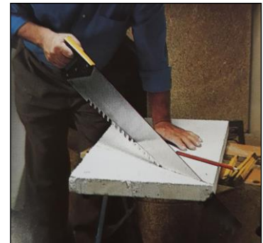
Fig. 5: Corte de una plancha para adaptarla al lateral de un precerco
