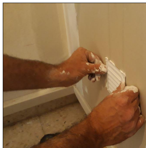
Fig. 11 y 12: Proceso de apertura de un hueco en un trasdosado de placa de yeso laminado para permitir la ventilación de la cámara de aire. Realización de corte con cuchilla retráctil y disposición posterior de rejilla de aluminio.
