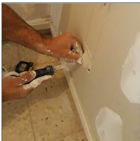
Fig. 11 y 12: Proceso de apertura de un hueco en un trasdosado de placa de yeso laminado para permitir la ventilación de la cámara de aire. Realización de corte con cuchilla retráctil y disposición posterior de rejilla de aluminio.
