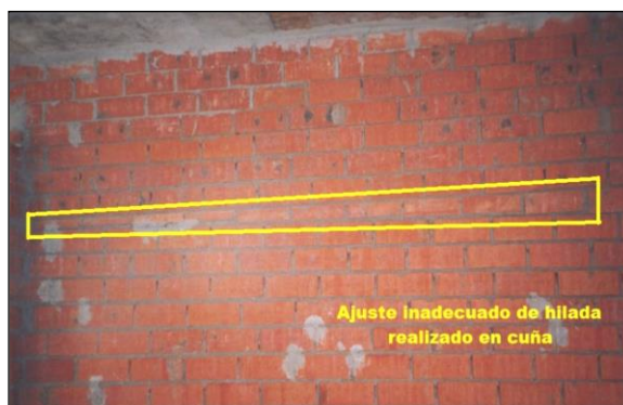
Fig. 2: Tabique de LP con realización de hilada irregular
