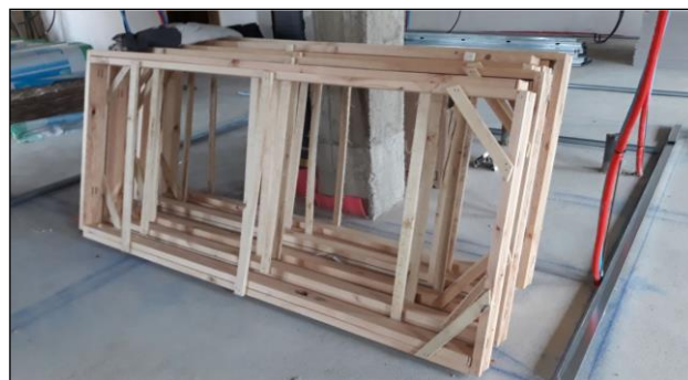
Fig. 3: Acopio en planta de varios precercos de madera de puertas de paso abatibles.
