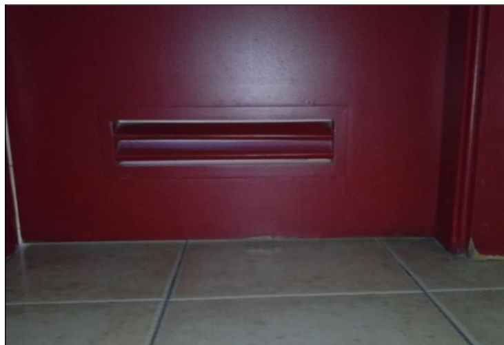
Fig. 5: Colocación de una abertura de paso integrada en la parte inferior de una puerta. Las lamas de la rejilla están fabricadas en madera y a doble cara.
