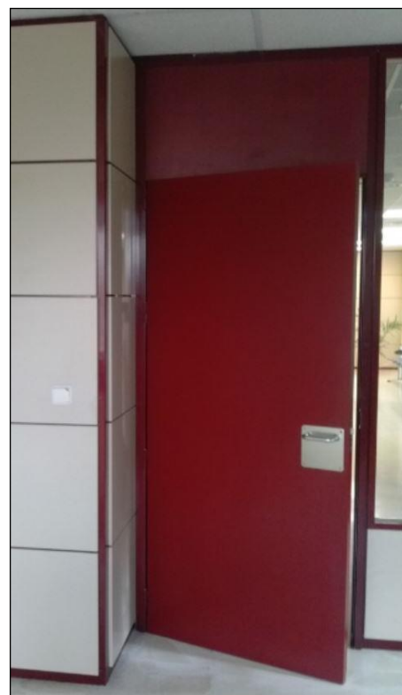
Fig. 3: Puerta de oficina con un fijo hasta el techo en la parte superior
