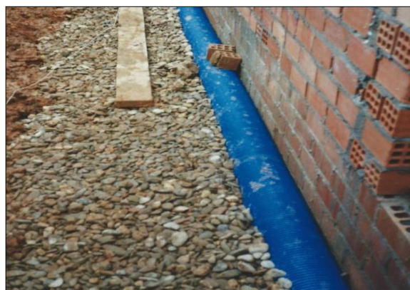
Fig.1: Tubo-dren dispuesto en contacto directo con fachada
