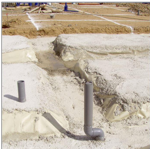
Fig. 6: Instalación de saneamiento colocada bajo una lámina de PVC y el hormigón de limpieza de una losa nervada de cimentación
