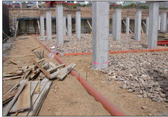
Fig. 1: Red de tipo 'cubierta', apoyada sobre cama de arena
