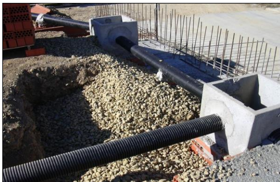
Fig. 2: Colectores de PVC corrugado y arquetas de hormigón
