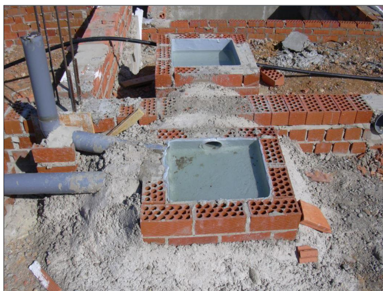
Fig. 5: Prueba de estanqueidad parcial de una red de saneamiento horizontal realizada mediante llenado de agua. Puede apreciarse también el macizado exterior con hormigón del encuentro entre tuberías y arquetas.
