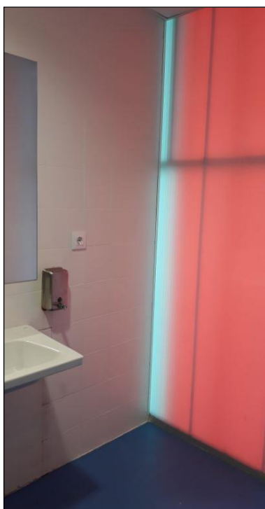
Fig. 4 y Fig. 5: Ejemplos de utilización del policarbonato como partición. A la izquierda como cierre de un baño usando piezas de color, y a la derecha en blanco para configurar el paramento divisorio entre un pasillo y varios despachos.
