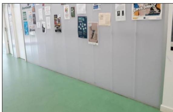
Fig. 2: Tabiques realizados con paneles de policarbonato
