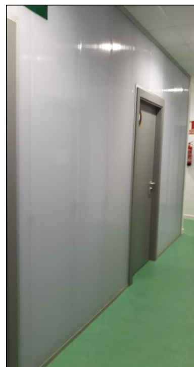
Fig. 4 y Fig. 5: Ejemplos de utilización del policarbonato como partición. A la izquierda como cierre de un baño usando piezas de color, y a la derecha en blanco para configurar el paramento divisorio entre un pasillo y varios despachos.
