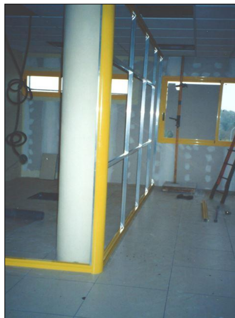
Fig. 7: Proceso de montaje de una tabiquería modular con subestructura portante metálica. Las esquineras, piezas de cornisa y piezas de rodapiés son de aluminio lacado, mientras que los perfiles interiores modulares son de aluminio anodizado.
