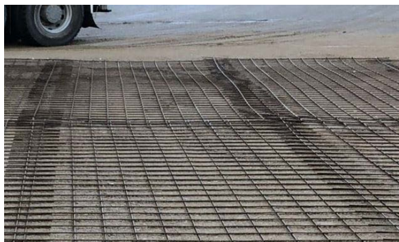
Figura 1: Ejecución solera de hormigón
