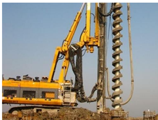
Fig. 1: Ejecución de pilotes
