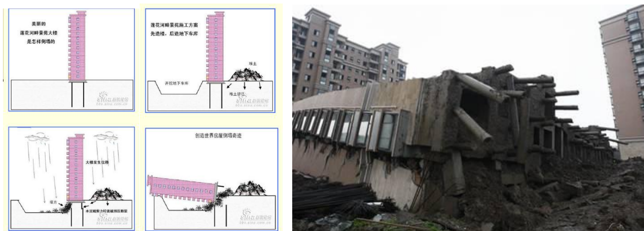
Figura 7: Caída de un edificio en Shanghai. China
