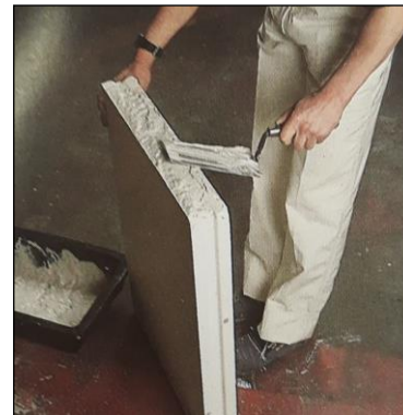
Fig. 4: Aplicación de adhesivo sobre el canto hembra de una plancha
