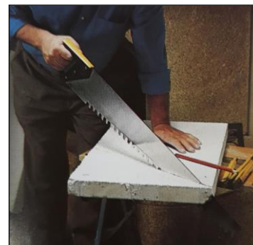
Fig. 5: Corte de una plancha para adaptarla al lateral de un precerco
