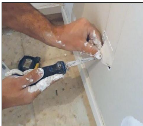
Fig. 11 y 12: Proceso de apertura de un hueco en un trasdosado de placa de yeso laminado para permitir la ventilación de la cámara de aire. Realización de corte con cuchilla retráctil y disposición posterior de rejilla de aluminio.
