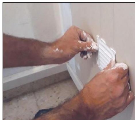
Fig. 11 y 12: Proceso de apertura de un hueco en un trasdosado de placa de yeso laminado para permitir la ventilación de la cámara de aire. Realización de corte con cuchilla retráctil y disposición posterior de rejilla de aluminio.
