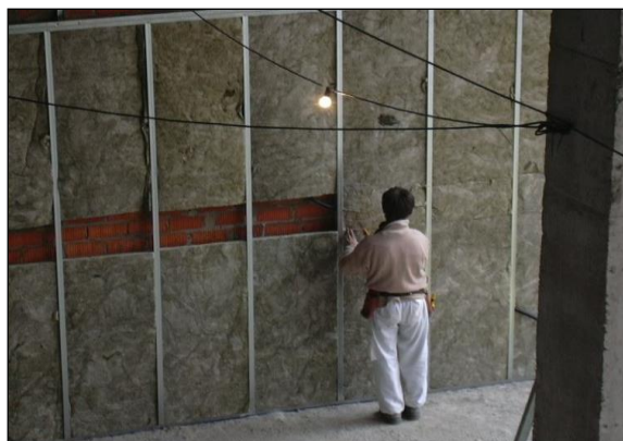
Fig. 1: Colocación de lana de roca en trasdosado autoportante
