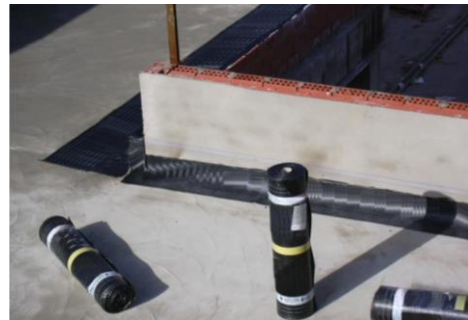
Fig. 4: Colocación de la 'banda de adherencia' en un encuentro con pretil (erróneamente no se ha aplicado antes una imprimación bituminosa líquida).
