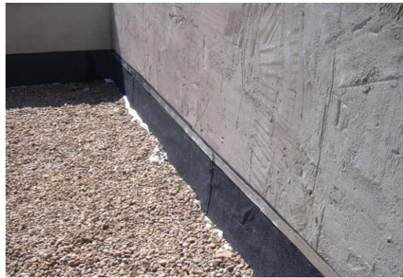
Fig. 1: Zona lateral de cubierta no transitable bituminosa
