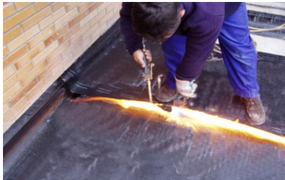
Fig. 2: Proceso de colocación de una lámina impermeabilizante
