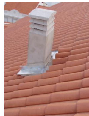
Fig. 7: Encuentro de un faldón con un "shunt"
