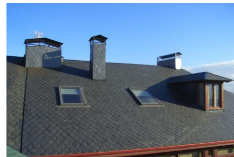
Fig. 6: Tejado de pizarra con la existencia de distintos puntos singulares: canalones, ventanas, chimeneas, juntas de dilatación...
