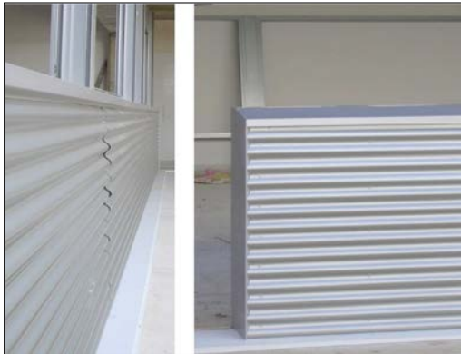
Fig.7: Fachada ligera de chapa metálica ondulada (vista lateral y frontal)
