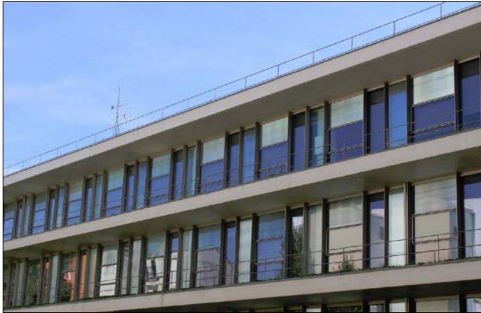
Fig.11: Fachada-panel con subestructura de aluminio anodizado y lunas de vidrio con áreas tintadas y no tintadas. Sobresale un voladizo con inclusión de vegetación sobre él
