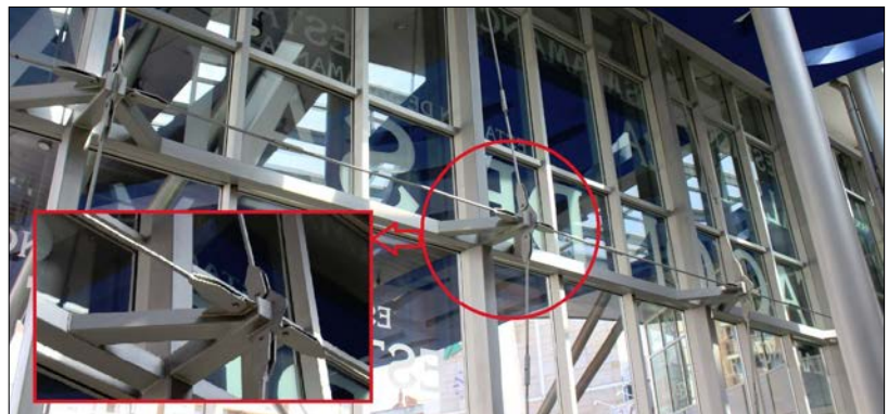
Fig.12: Fachada con vidrios insertos entre montantes y travesaños de aleación ligera, que dispone de una estructura soporte de refuerzo posterior con perfiles metálicos unidos por medio de tensores de acero.
