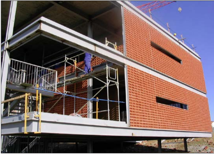
Fig.9: Ejecución de fachada con piezas cuadradas de celosía cerámica
