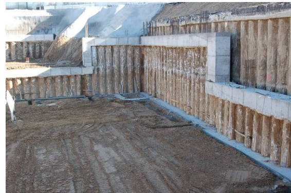
Fig. 2: Ejecución pantalla de pilotes
